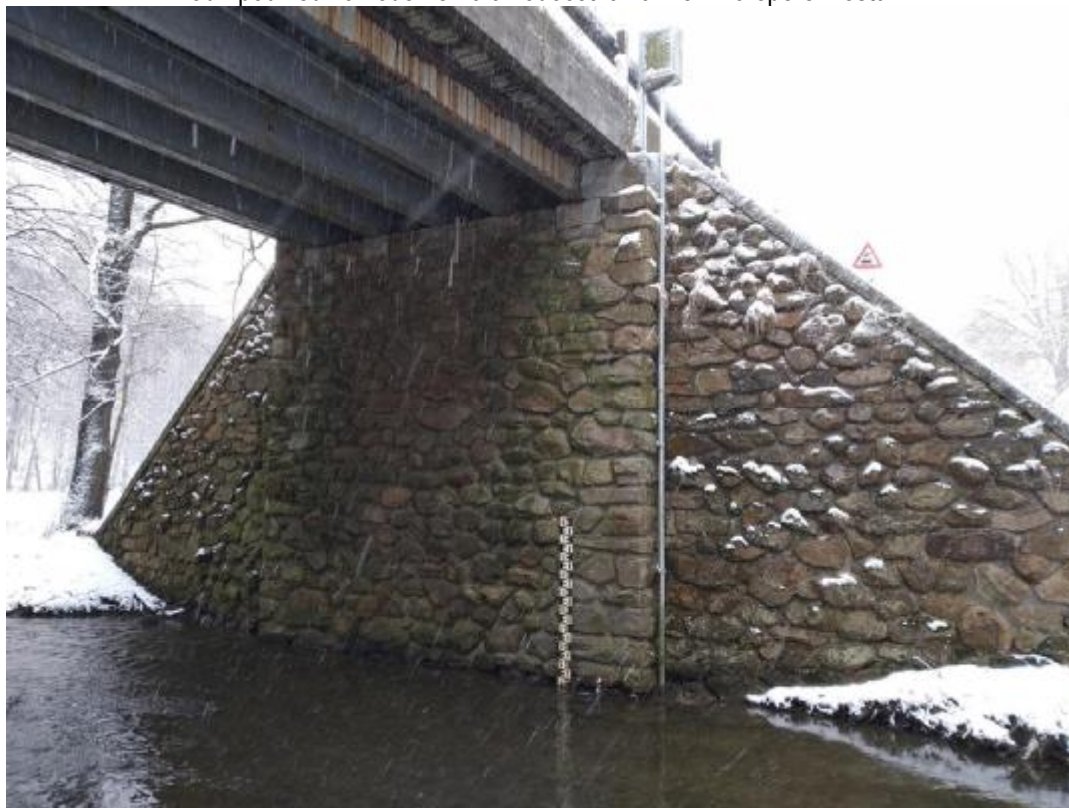
obr. pohled na vodoměrná a vodočetná zařízení na opěře mostu
